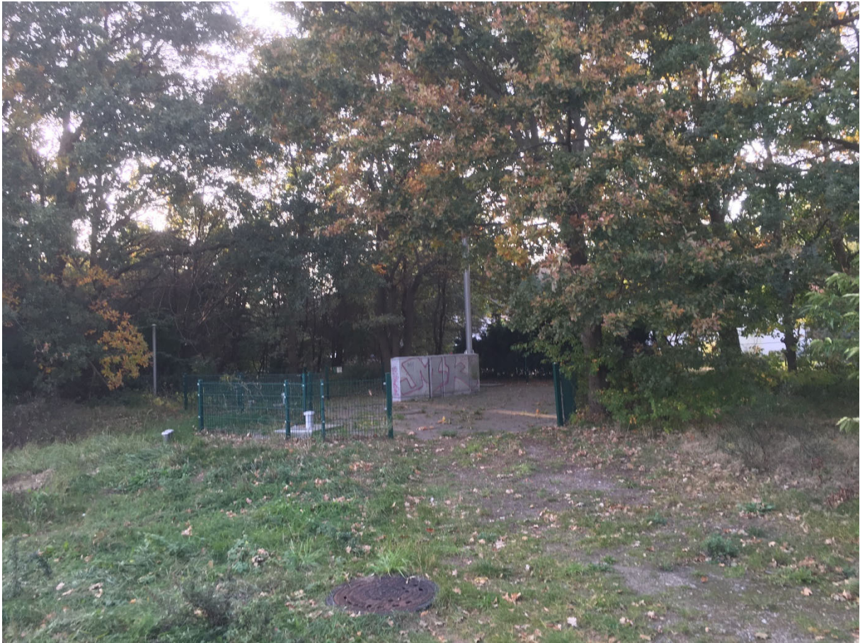
Bild 1: Ansicht der Abwasserpumpstation in der Lindenstraße in Pruchten
