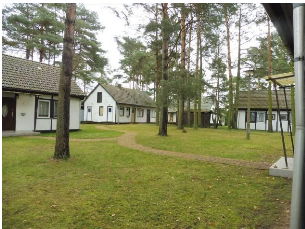
Foto 3: Altbestand an Ferienhäusern
