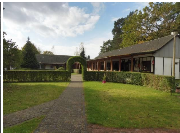
Foto 4: Gebäudebestand mit Infrastruktur im Westen
