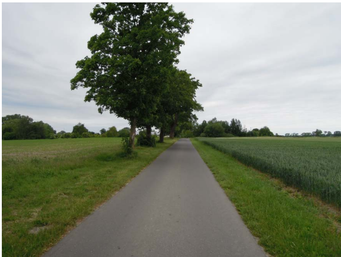
Abbildung 21: Blick von der Dorfstraße auf Höhe von Planteil 2 und 3 in Richtung Nordwesten, eigenes Foto 10.06.2020
